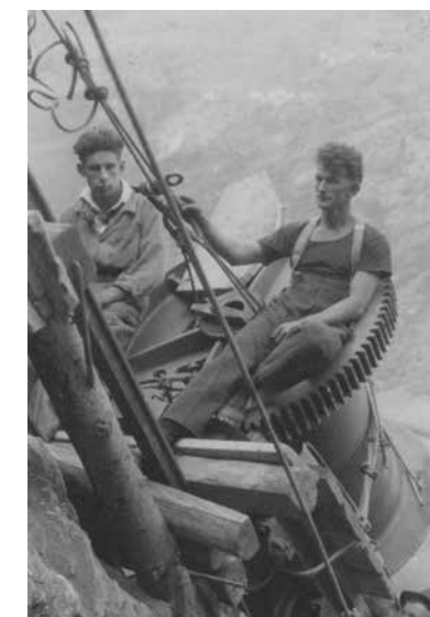
Lago Tremorgio, costruzione condotta, 1918
