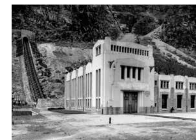
Vecchia centrale Biaschina, 1916
